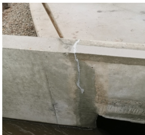
1 pav. Supleišėjusi konstrukcija Fig. 1. Cracked structure
